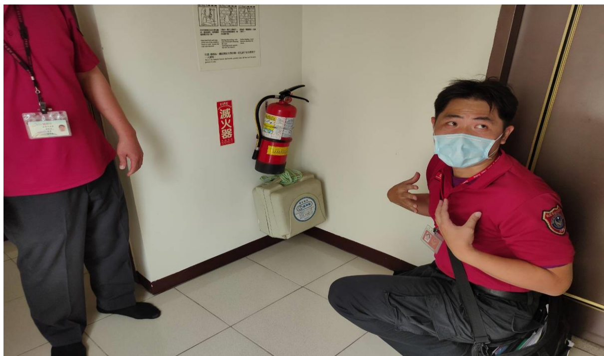
消防人員檢查消防設施狀況(1)
