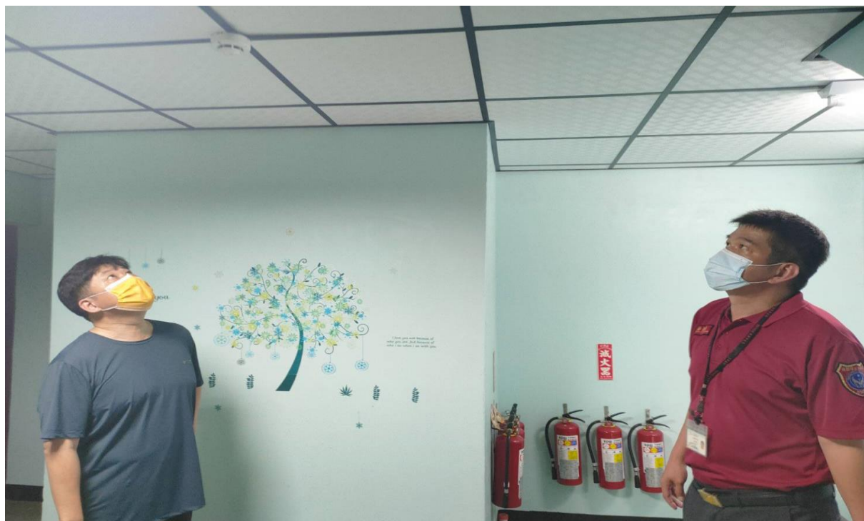
消防人員檢查消防設施狀況(2)
